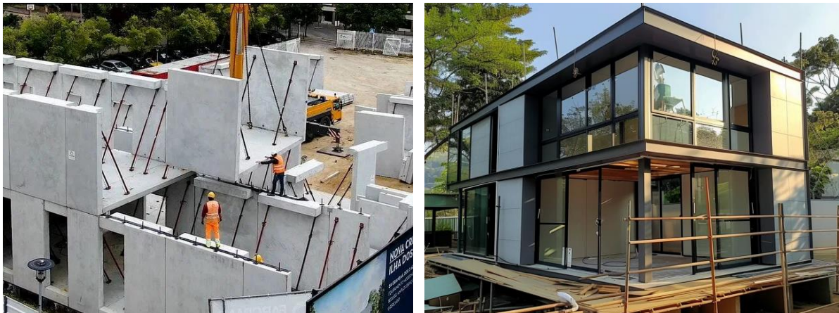
شکل ۴. استفاده از قطعات بتنی پیش‌ساخته در تولید واحدها و منازل مسکونی
