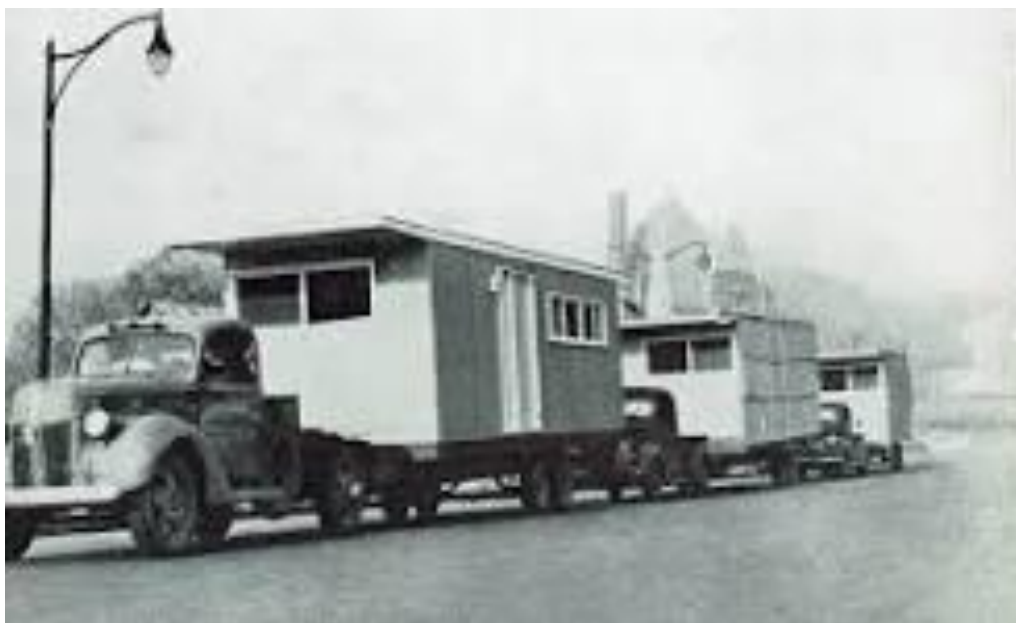
شکل ۱۴- نمونه ای از ساختمانهای کوچک بتنی پیش ساخته بتنی در ابتدای قرن بیستم
