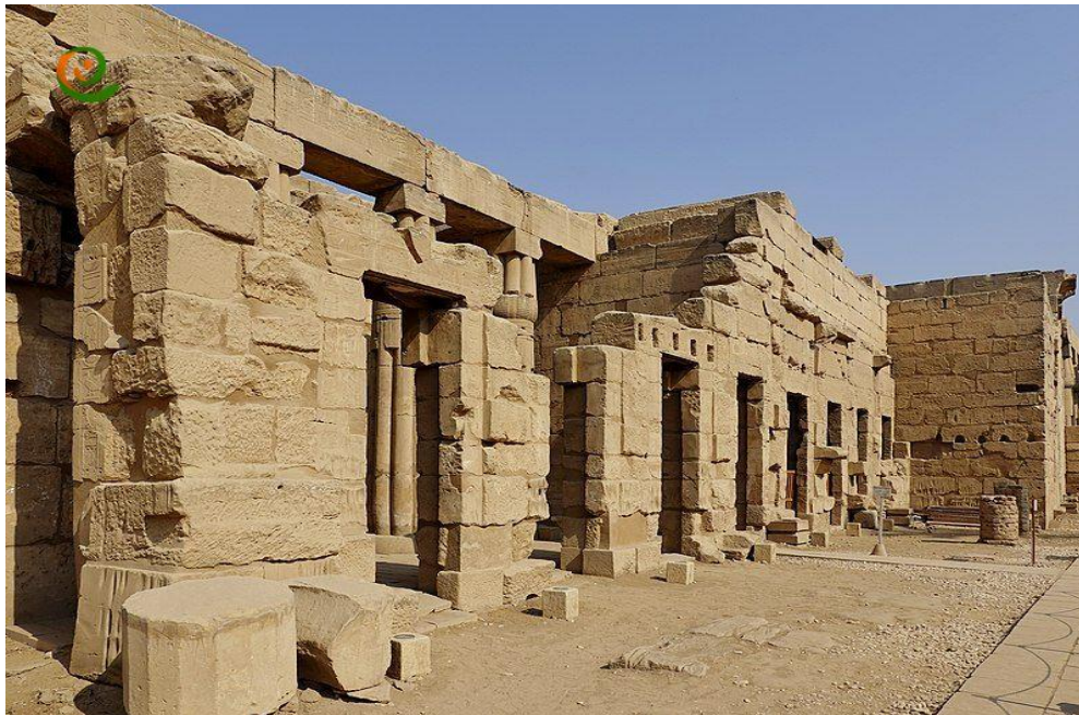
شکل ۲_ در مصر باستان بیشتر بناها با انتقال قطعات سنگی برش خورده ساخته شده اند
