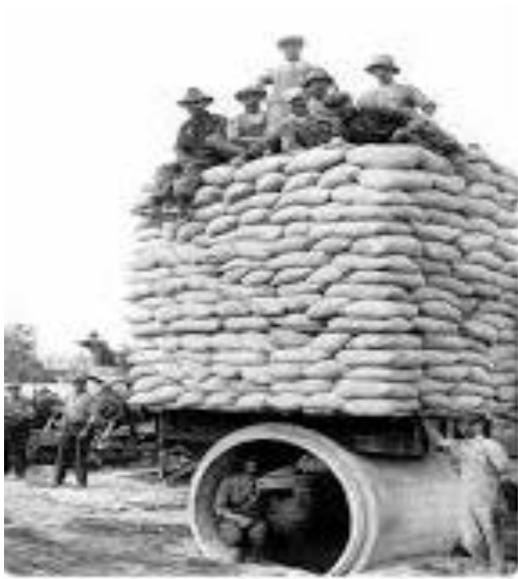
شکل ۱۳- تست لوله پیش ساخته بتنی در زیر بار ۲۱ تنی (کانادا)
