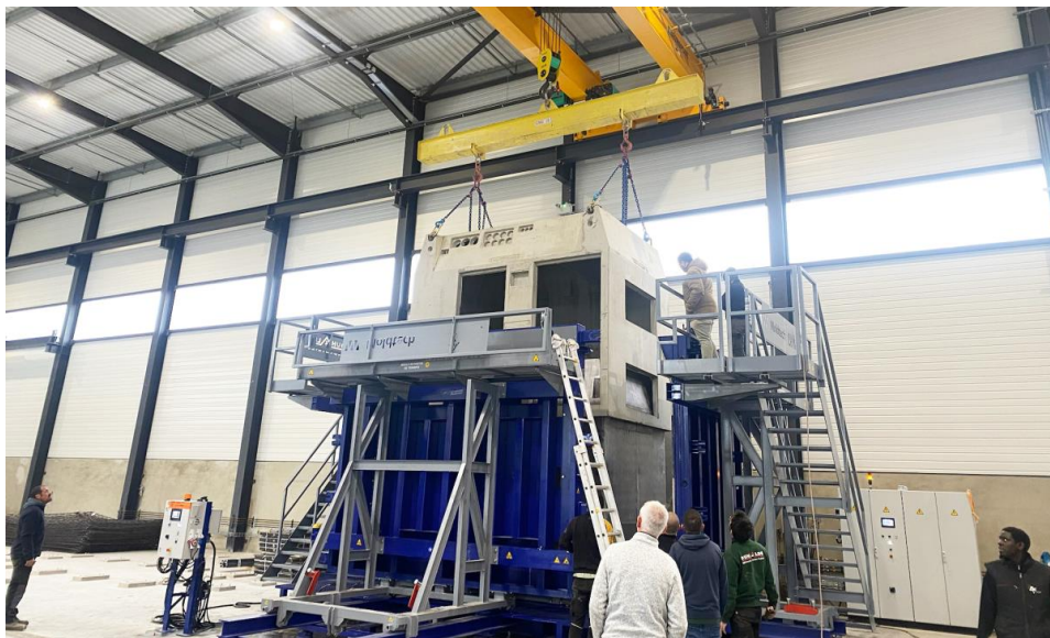
شکل ۳-۲۵ - تولید قطعات حجمی به صورت ایستگاه ثابت ( ایستا ) در کارخانه
